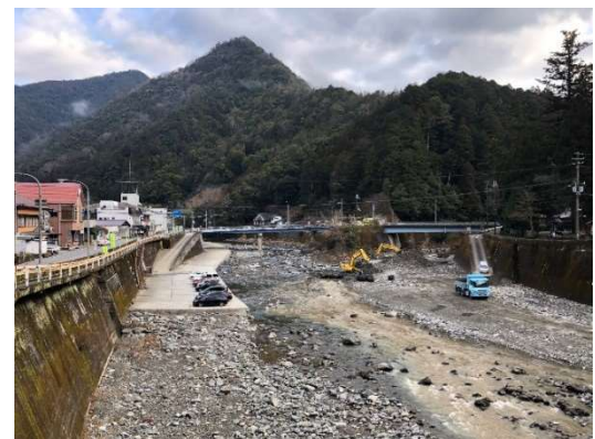
堆積土砂撤去(北山川)
